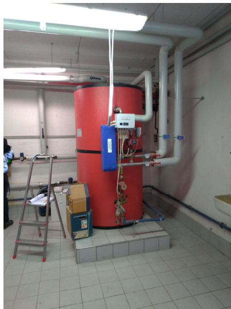
Fig. 2 – serbatoio accumulo acqua calda sanitaria con scambiatore esterno
