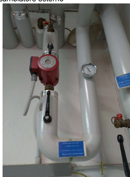
Fig 4 - condotto ricircolo acqua calda sanitaria con relativa pompa
