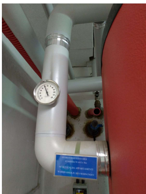
Fig. 3 – condotto mandata acqua calda sanitaria in uscita dal boiler
